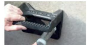
3. Posizionare l'ancoraggio EJOT® attraverso il foro del gradino in ferro utilizzando il metodo push through.
